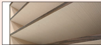
地板(スラセ)の上部は桐シート貼り仕上
